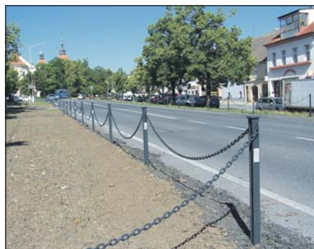
Sloupky s řetězy jsou již po obou stranách hlavní smečenské silnice.
